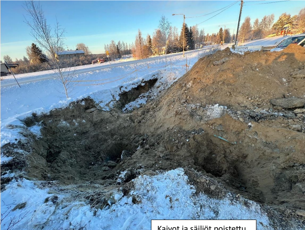
Kaivot ja säiliöt poistettu.
