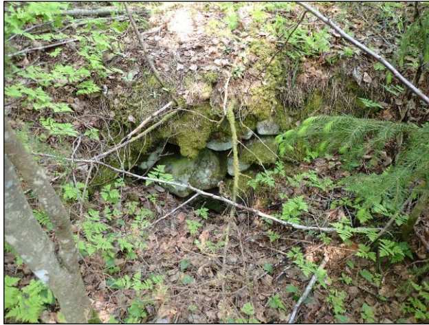
Tervahaudan Alavus Iso-Sikanen halssiojan luoteispään kivirakenne.
